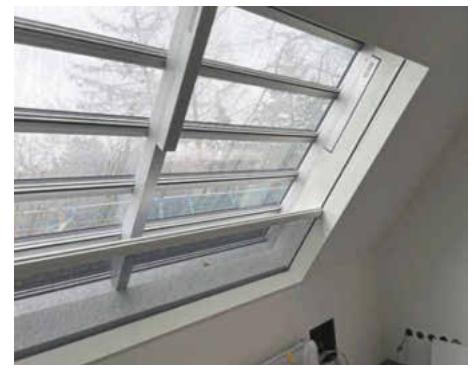
/ Vor den motorisierten Dachflächen-Lamellenfenstern im Inneren wurde ein textiler Sonnenschutz montiert.
