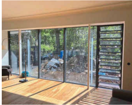
/ Die bodentiefen Fenster sorgen für viel Tageslicht und die Lamellenfenster (r.) für eine natürliche Lüftung.
